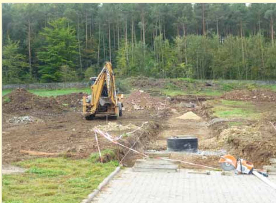
Prace remontowe na cmentarzu
